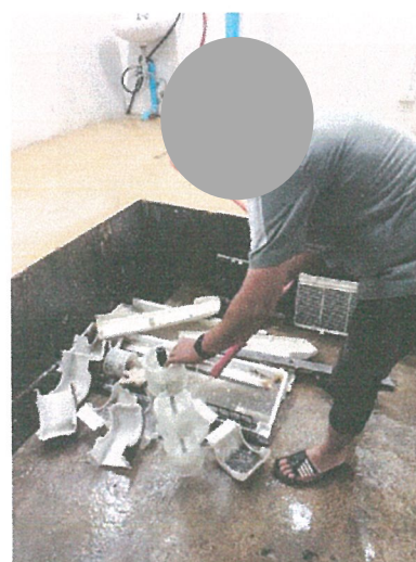
รูปภาพที่ 2.42 การทำความสะอาดเครื่องปรับอากาศ/ถาดรองรับน้ำ และอุปกรณ์ระบายอากาศ
