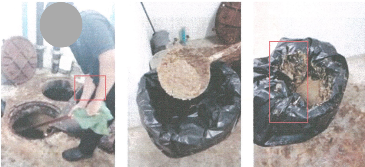
รูปภาพที่ 2.32 การตัดไขมันในบ่อดักไขมัน
