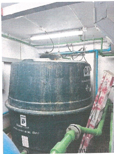
รูปภาพที่ 2.3 บ่อพักน้ำและตะแกรงดักมูลฝอย
