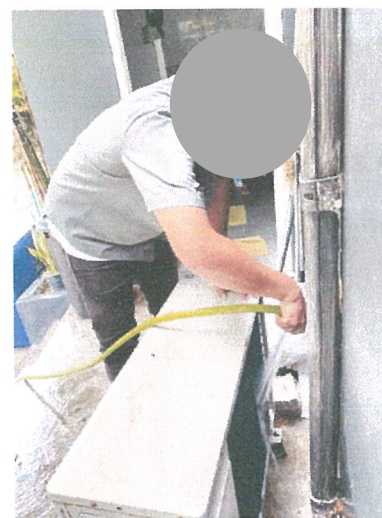
รูปภาพที่ 2.42 การทำความสะอาดเครื่องปรับอากาศ/ถาดรองรับน้ำ และอุปกรณ์ระบายอากาศ
